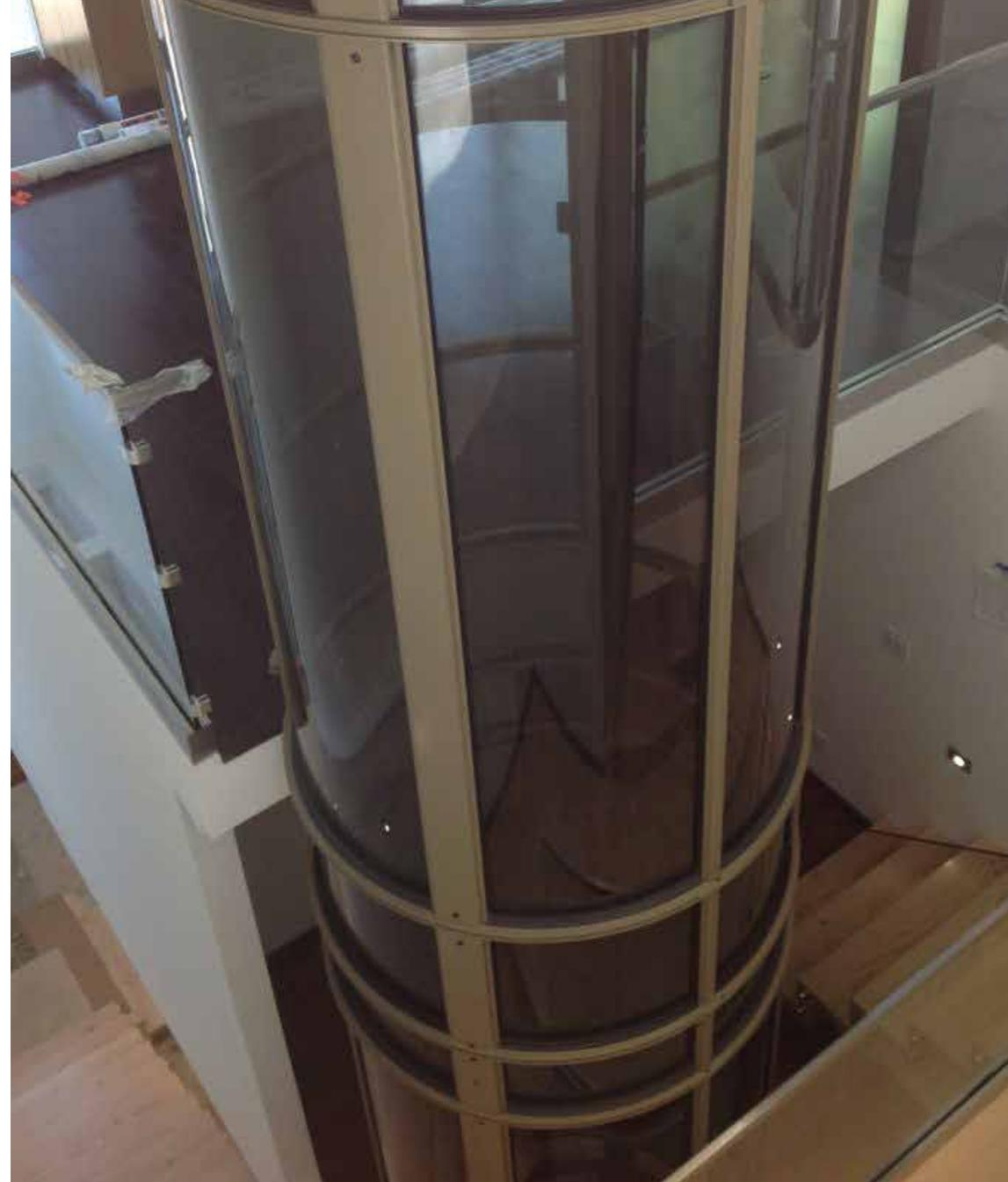
Installation en cage d'escalier et au travers du plancher
